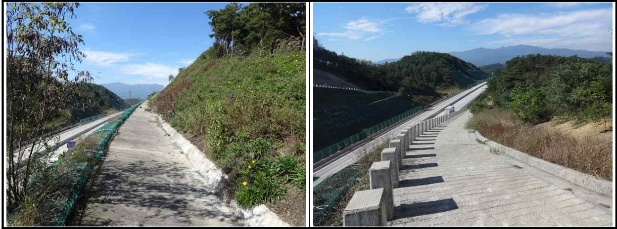
【그림 47.3.3】 배수시설 전경
