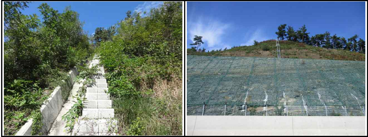
【그림 47.3.4】 보호/보강시설 전경
